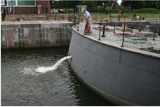
De schipdeur wordt leeggepompt.
